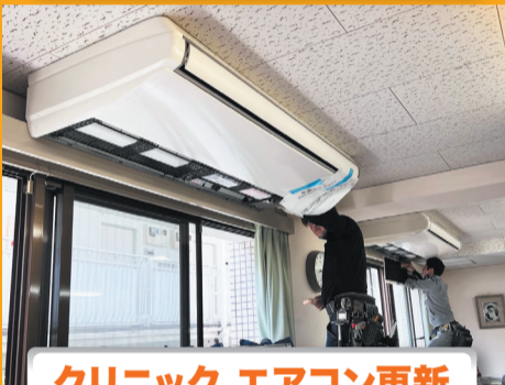
クリニック エアコン更新
