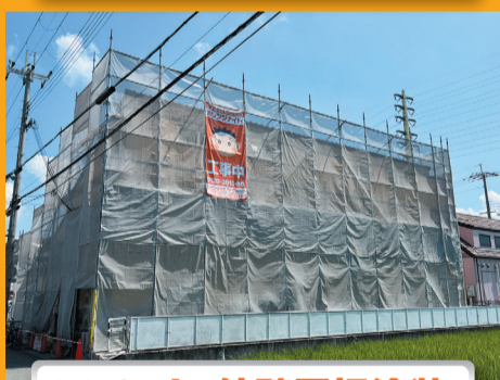
アパート 外壁屋根塗装
