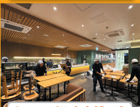
カフェ ビル内店舗工事
