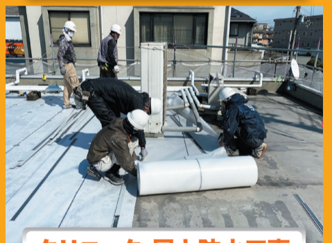
クリニック 屋上防水工事
