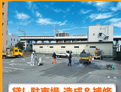
貸し駐車場 造成&補修
