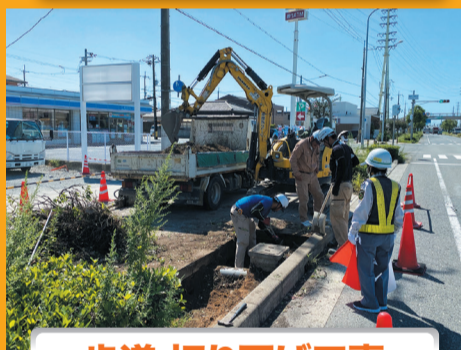
歩道 切り下げ工事
